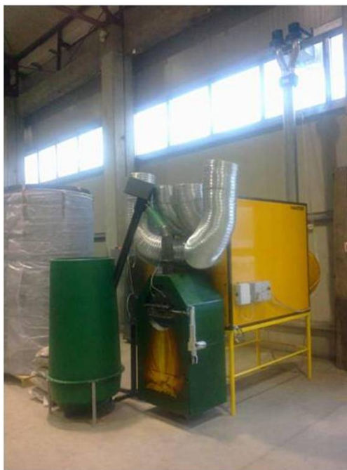
Arzator tip injector ecoHORNET AHP 200 kw montat pe generator aer cald Master 220 kW-Debit 12.500 mc/h la 70°C ( A fost inlocuit injectorul pe motorina 200 Kw) Cost de exploatare: motorina 20L x 1,4 Euro = 28 Euro/ora, peleti = 40 kg x 0,12 = 4,8 Euro/ora (120 Euro/tona)
