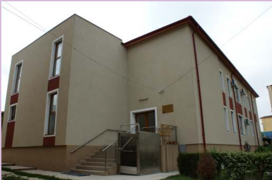
Proiect: Reabilitare, modernizare și dotare la Centrul de Recuperare și Reabilitare Neuropsihiatrică Techirghiol - Corpul C, în vederea înființării unui Centru de Îngrijire și Asistență Techirghiol Beneficiar: PARTENERIATUL DINTRE UAT JUDEȚUL CONSTANȚA ȘI DGASPC CONSTANȚA
