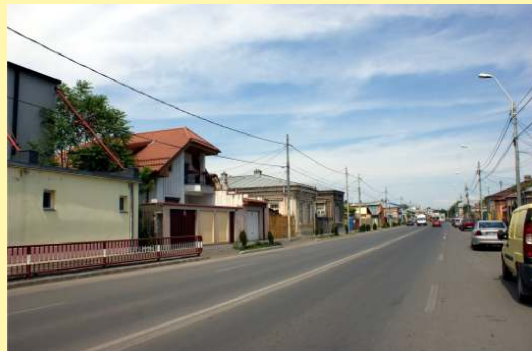
Proiect: Reabilitarea și modernizarea str. Grivița în municipiul Brăila Beneficiar: UAT MUNICIPIUL BRĂILA
