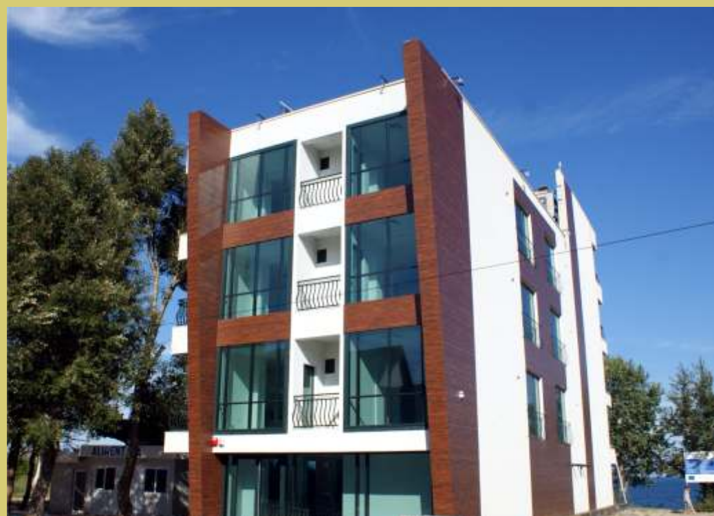
Proiect: Continuare lucrări cu modificare de proiect, construire clădiri și birouri (Centru de afaceri) Beneficiar: S.C. INTERCONSTRUCT S.R.L.
