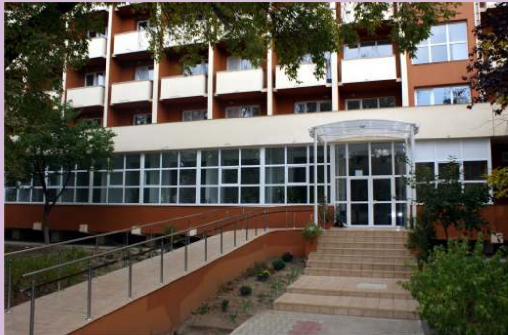
Proiect: Modernizarea clădirilor Căminului pentru persoane vârstnice „Sfântul Spiridon” Galați Beneficiar: UAT MUNICIPIUL GALAȚI
