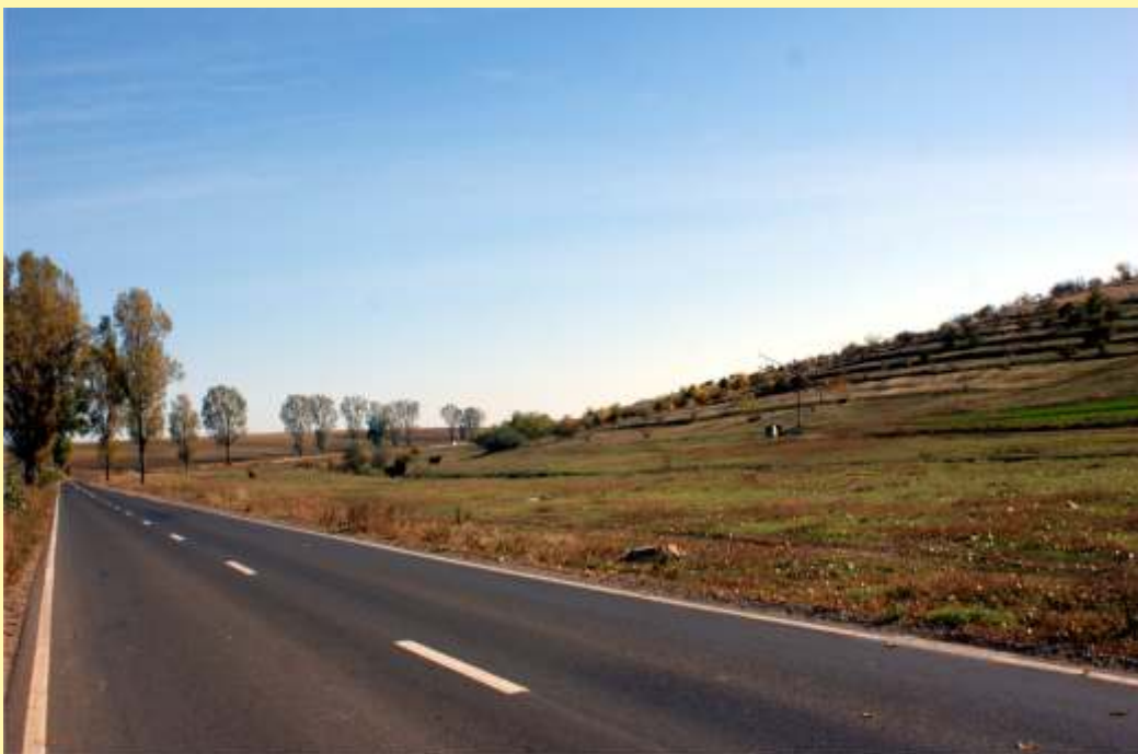
Proiect: Reabilitare și modernizare DJ 251 între municipiile Tecuci și Galați, sector Km 24+000-53+350 Beneficiar: UAT JUDEȚUL GALAȚI - LIDER PARTENERIAT
