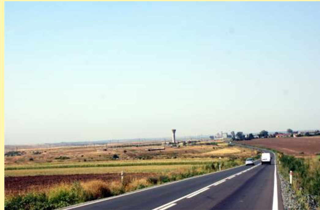
Proiect: Reabilitare și modernizare de drumuri județene, tronsonul DJ228: DN22C (Nazarcea) - DN 2A (Ovidiu) Beneficiar: UAT JUDEȚUL CONSTANȚA
