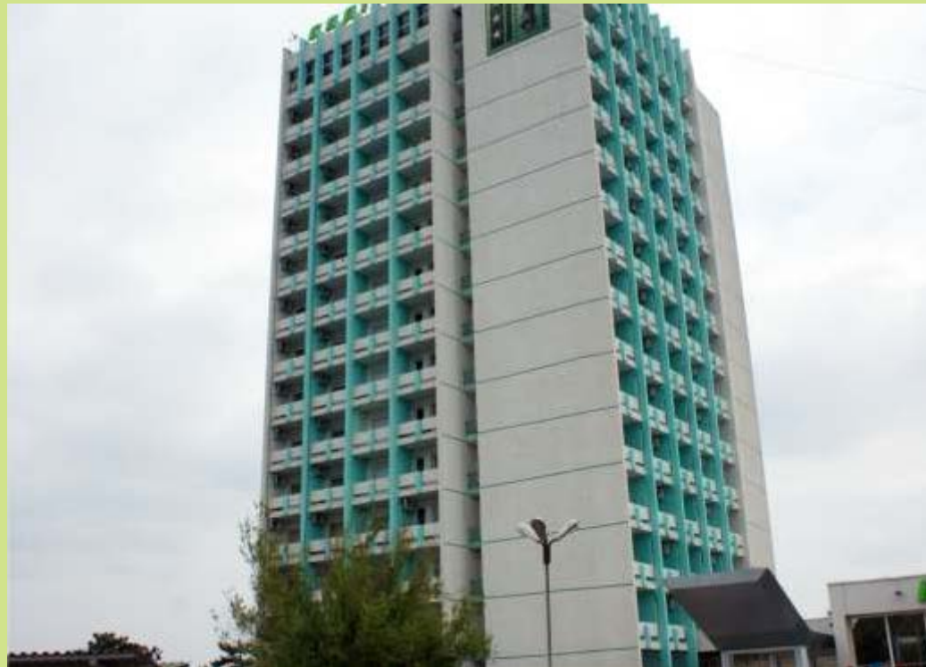
Proiect: Modernizare Hotel Capitol, stațiunea Jupiter Beneficiar: S.C. CAPITOL S.A.
