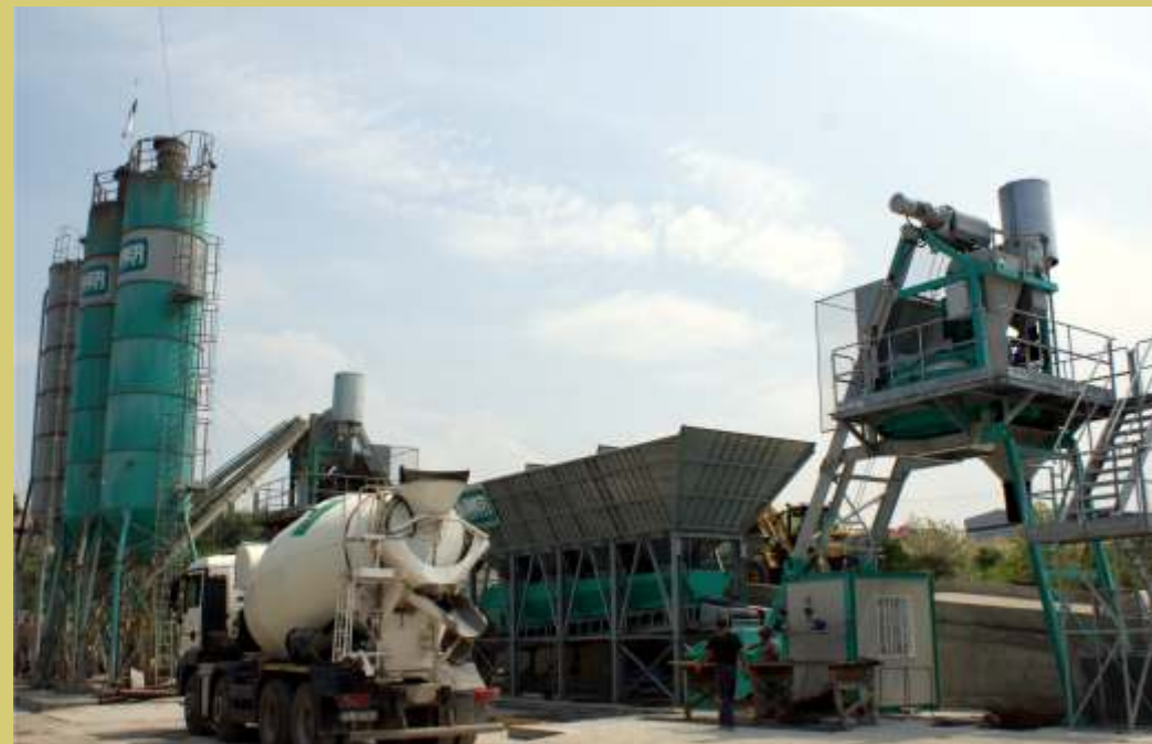
Proiect: Creșterea competitivității firmei prin achiziționarea unei stații mobile de preparare betoane specifică în construcțiile hidrotehnice Beneficiar: S.C. STUDIO FORMA S.R.L.
