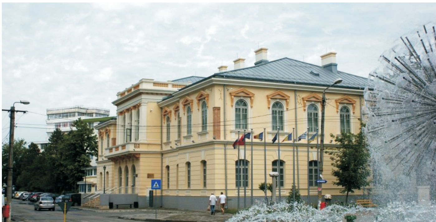
Titlul proiectului: Restaurarea si reabilitarea a două clădiri de patrimoniu din Municipiul Tulcea incluse în circuitele turistice regionale Beneficiar: UAT JUDEȚUL TULCEA
