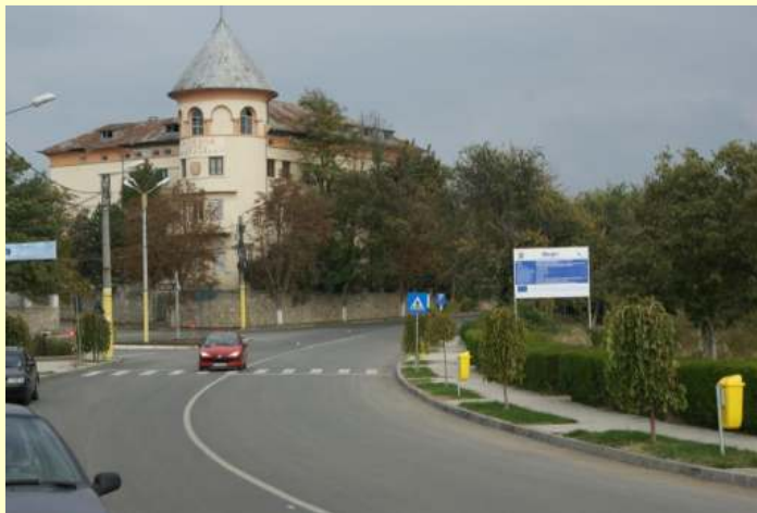
Proiect: REABILITAREA ȘI MODERNIZAREA DE DRUMURI ÎN STAȚIUNEA TECHIRGHIOI Beneficiar: UAT JUDEȚUL CONSTANȚA
