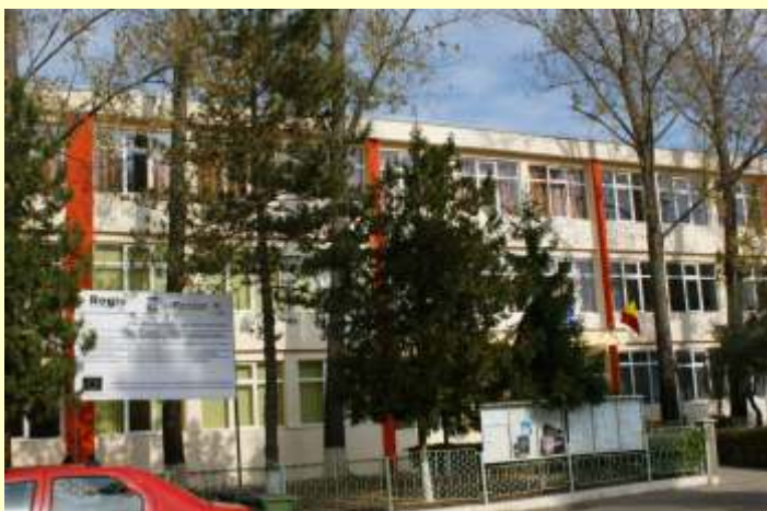
Proiect: REPARAȚII CAPITALE LA LICEUL CU PROGRAM SPORTIV BRĂILA Beneficiar: UAT MUNICIPIUL BRĂILA
