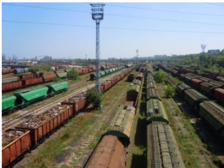
Figura 8.6 Vedere linii de garare în Portul Constanța
