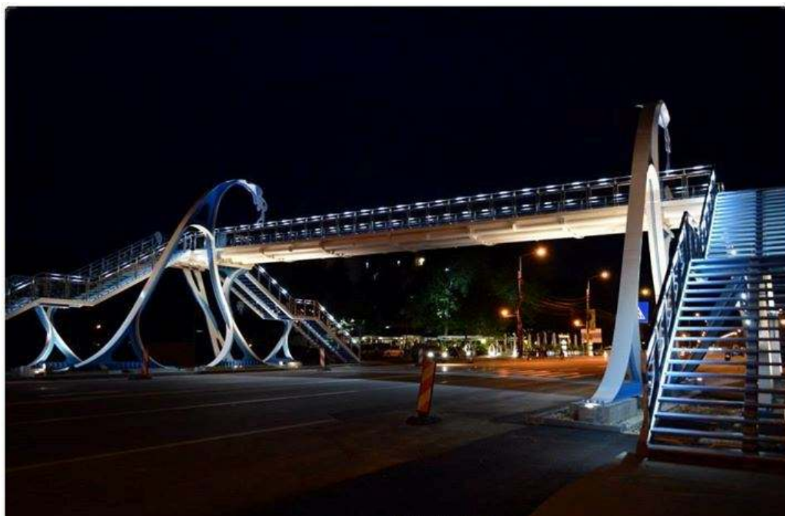
Pasarela Val Retro
