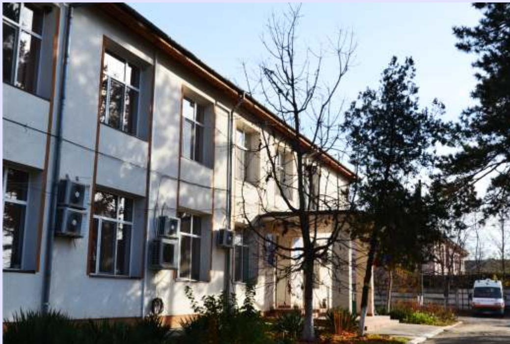
Proiect: Reabilitarea, modernizarea și echiparea ambulatoriului de specialitate al Spitalului de boli cronice - Smeeni Beneficiar: UAT COMUNA SMEENI
