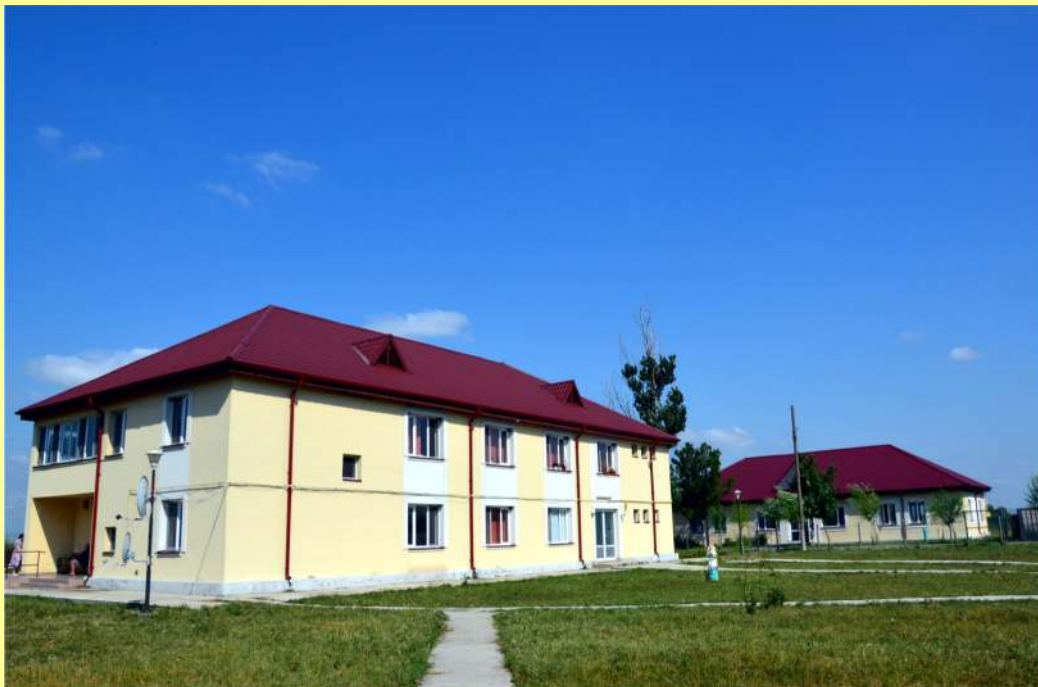
Proiect: "Reabilitarea și dotarea cu echipament specific a corpurilor D, E, F ale Centrului de asistență paliativă "Sfânta Maria" Brăila Beneficiar: UAT MUNICIPIUL BRĂILA
