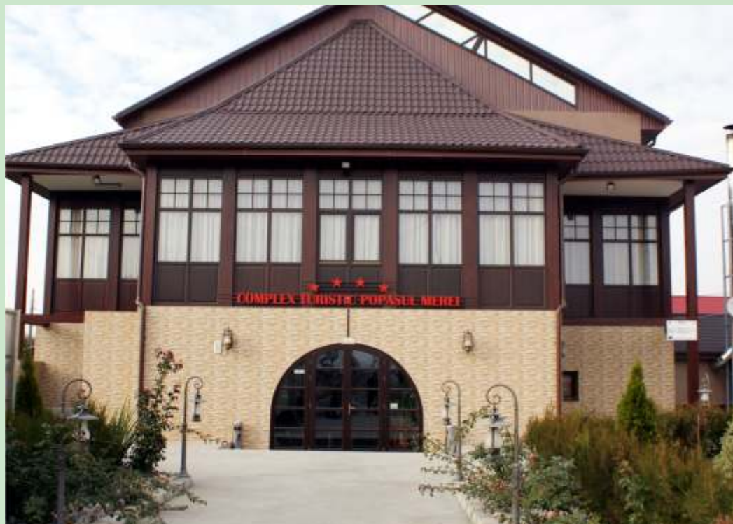
Proiect: Modernizarea hanului turistic Popas Merei Beneficiar: S.C. FLORION ANDREI S.R.L.
