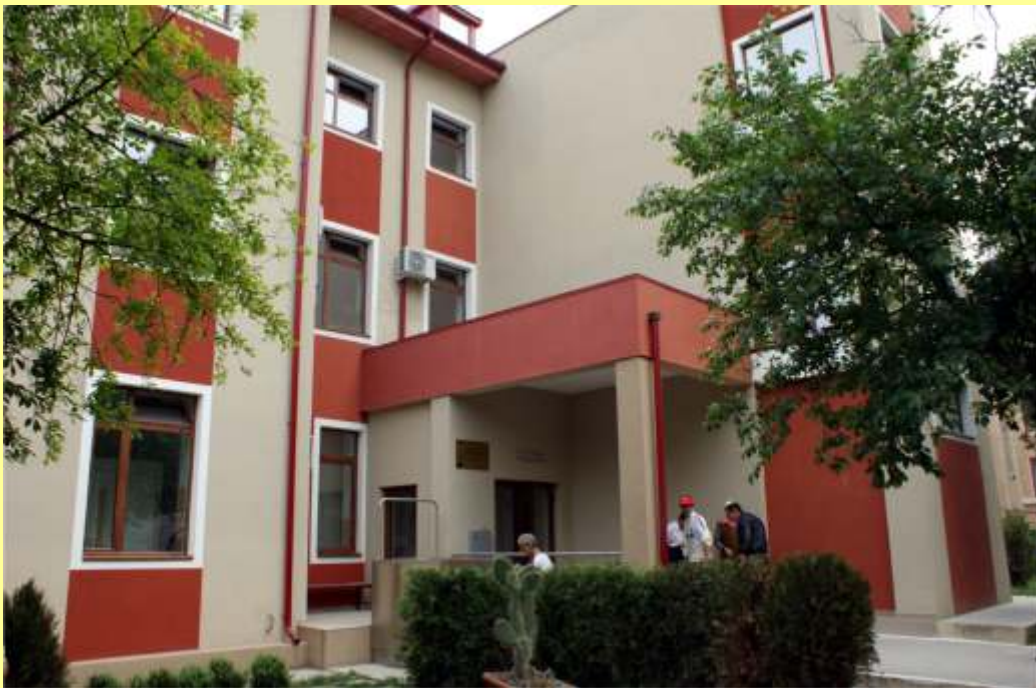
Proiect: Reabilitare, modernizare și dotare la Centrul de Recuperare și Reabilitare Neuropsihiatrică Techirghiol - Corpul A Beneficiar: PARTENERIATUL DINTRE UAT JUDEȚUL CONSTANȚA ȘI DGASPC CONSTANȚA
